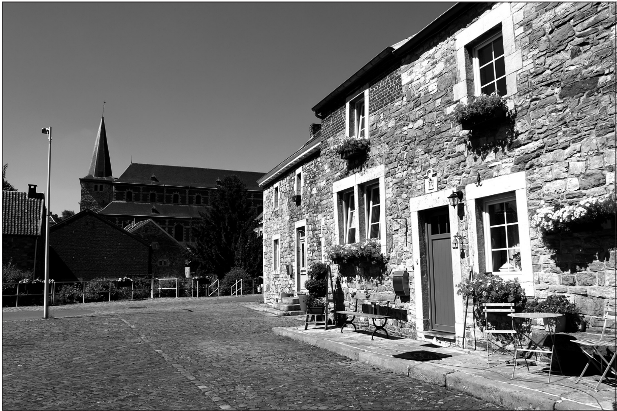
Photo 3. Soiron – réhabilitation des espaces publics
