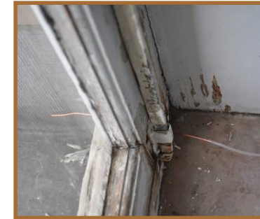
Mesure de la pression extérieure
