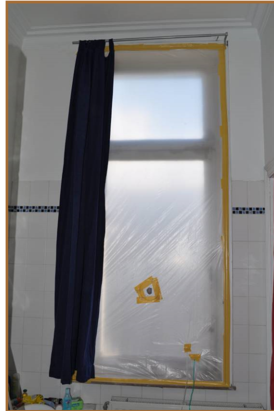
Film étanche à l'air fixé sur l'ébrasement intérieur
