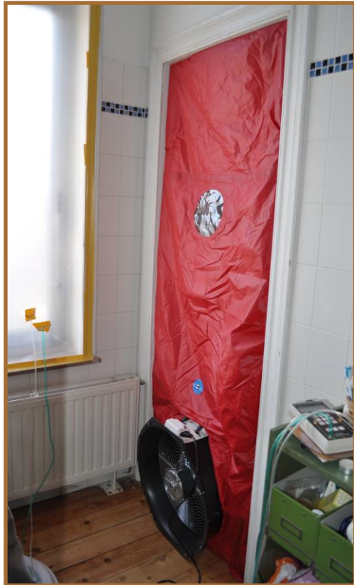
Ventilateur créant la dépression (dans ce cas) dans le local
