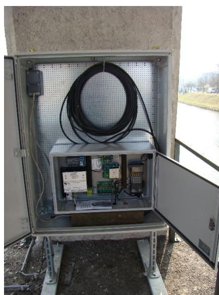
Figure 9. Au-dessus à gauche: antenne de détection RFID placée en 2012 au niveau d'une échancrure à l'amont de l'échelle à poissons du barrage des Grosses Battes sur la Basse Ourthe à Liège Au-dessus à droite : nouvelle antenne installée le 9 mars 2015. En dessous : station d'enregistrement des données logée dans une armoire métallique spécialement installée sur la pile du barrage mobile.
