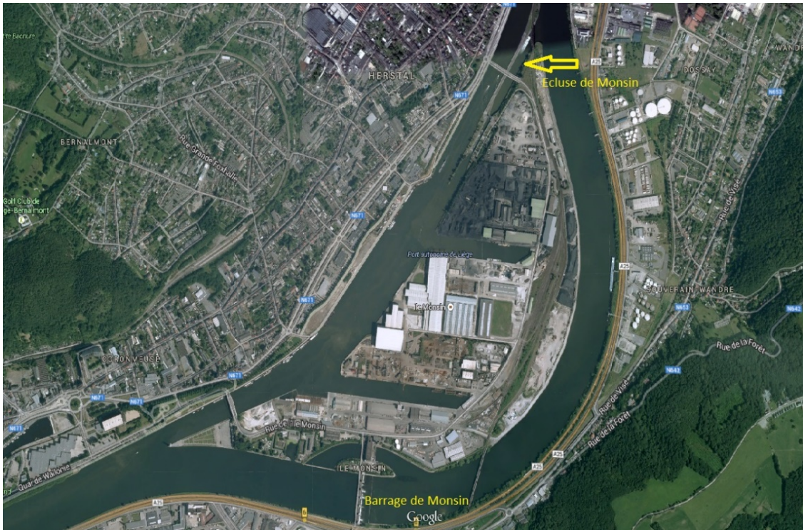
Figure 12. Vue aérienne du barrage de Monsin et de l'écluse de Monsin par où les poissons peuvent bifurquer vers le canal Albert et remonter vers la Meuse, sans passer par l'échelle à poissons du barrage de Monsin.
