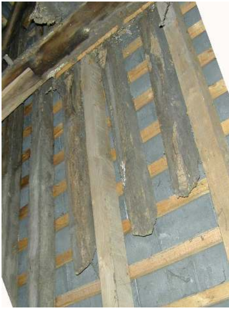
Fig. 107. Comble. Chevrons découpés au droit de la cheminée.
