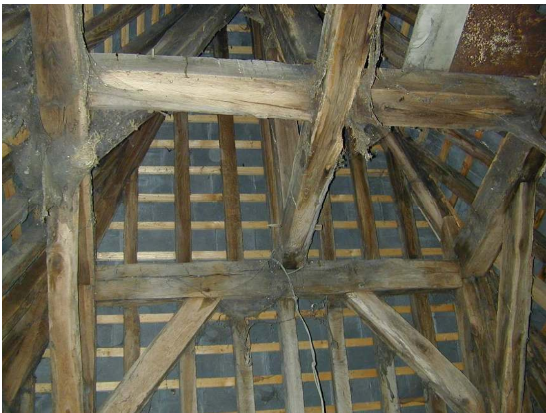
Fig. 48. Pavillon. Comble. Vue de la partie haute de la charpente. IG 2002.
