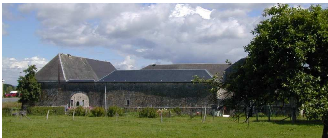
Fig. 8. Vue de la ferme Hogge, IG 2002.
