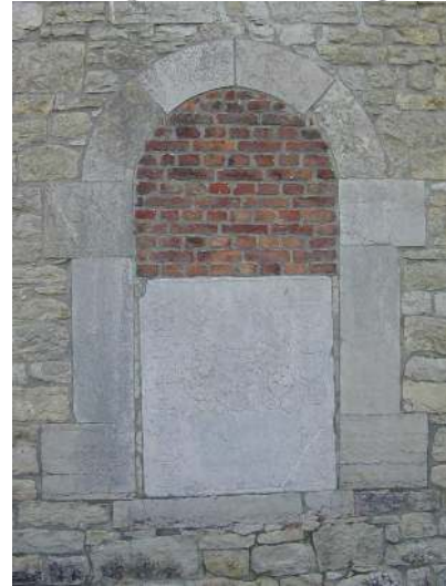
Fig. 55. Chapelle. Baie murée de l'élévation NO, encadrant la dalle votive. IG 2002.
