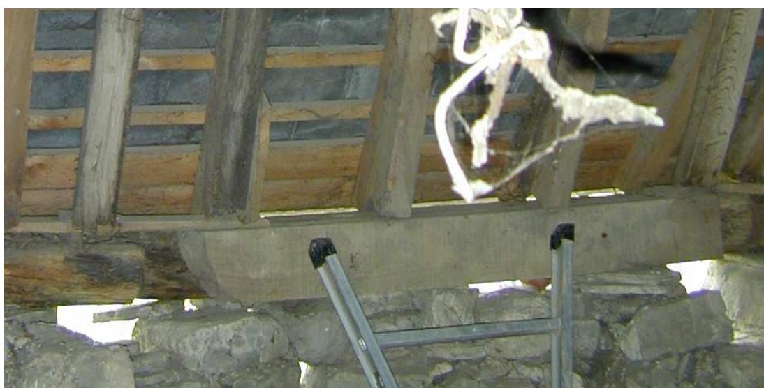
Fig. 106. Comble. Versant SE. Renfort de la sablière par pièce de chêne. IG 2004.
