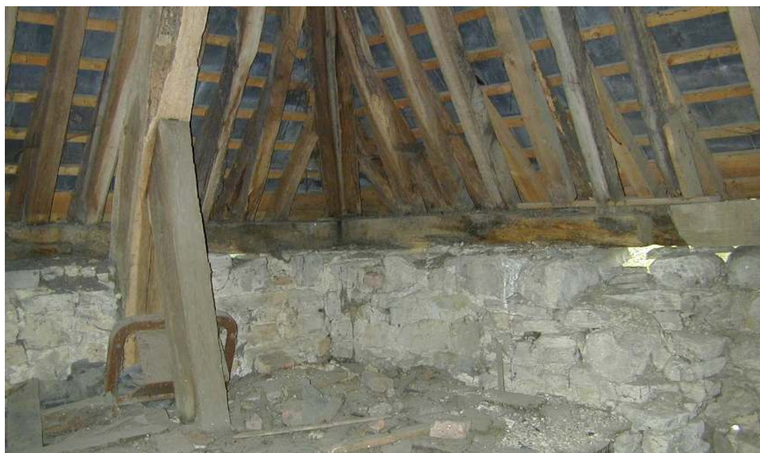
Fig. 101. Comble. Détail maçonnerie en surcroît. IG 2003.
