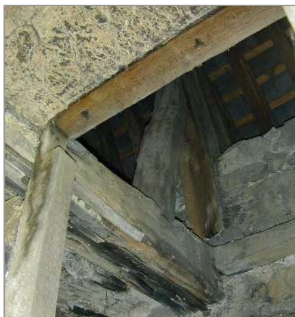
Fig. 100. Comble. Trappe d'accès. IG 2003.
