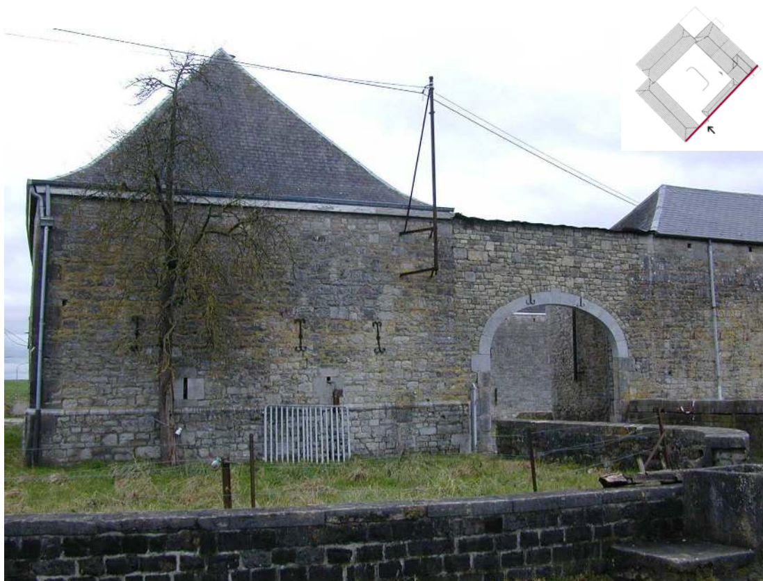
Fig. 52. Ferme. Vue des élévations encadrant l'entrée. Pignon du corps d'étable Nord. IG 2003.
