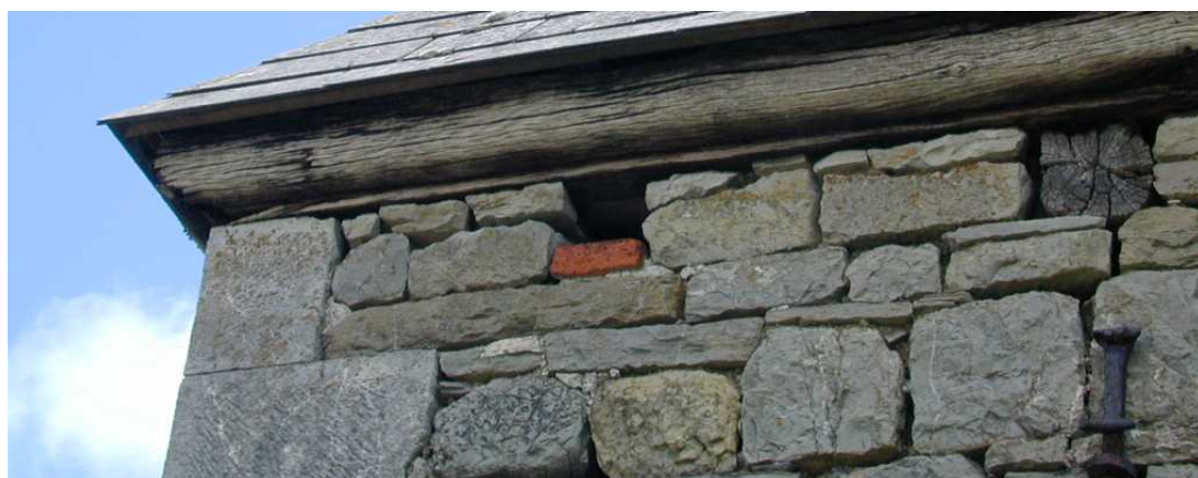
Fig. 86. Pavillon. Elévation Sud-Ouest. Détail du sommet des maçonneries. IG 2003.
