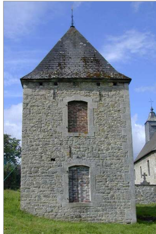
Fig. 30. Pavillon. Elévation NE. IG 2002.
