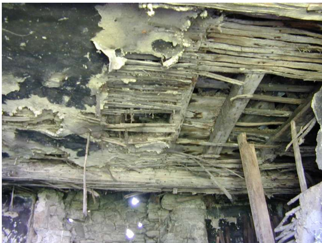
Fig. 94. 1 er étage. Plafond : solives, lattis et plafonnage. Vue vers la cheminée. IG 2003.
