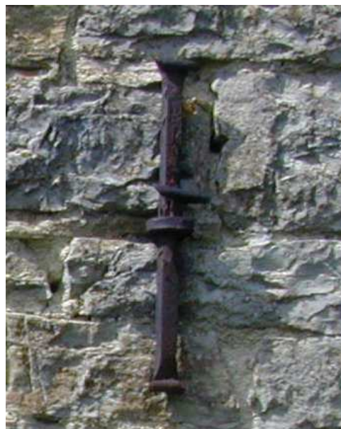
Fig. 87. Détail d'une ancre. Façade Sud-Est. IG 2003.
