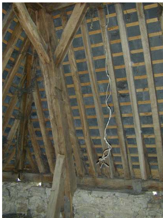
Fig. 47. Pavillon. Comble. IG 2002.
