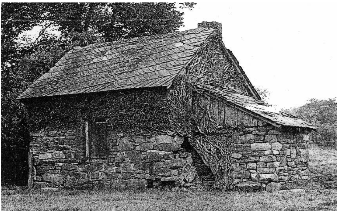
Fig. 153. « (...) Version plus courante, bien individualisée par ses deux toitures distinctes couvrant la pièce du four et le four proprement dit, sous appentis. Iveldingen à Amel, 19 e s. » GÉNICOT 1992, p. 205.
