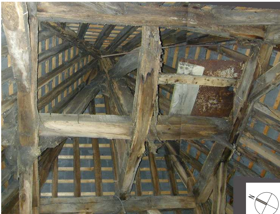
Fig. 98. Comble. Charpente. Entretoise, poinçon et jambettes. Montage photo IG 2007.
