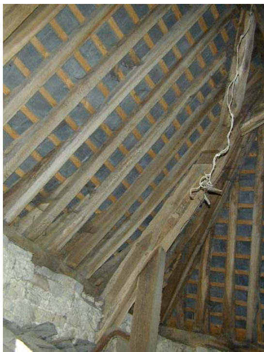
Fig. 46. Pavillon. Comble. IG 2002.
