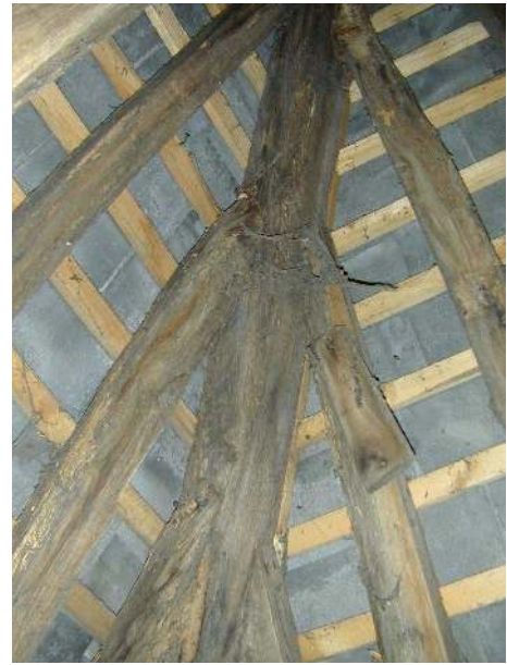
Fig. 108. Comble. Arêtier.
