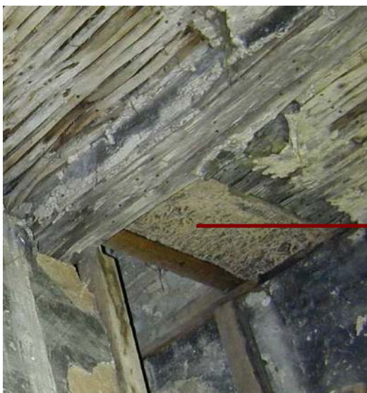
Fig. 91. 1 er étage. Plafond. Détail remplissage torchis. IG 03.
