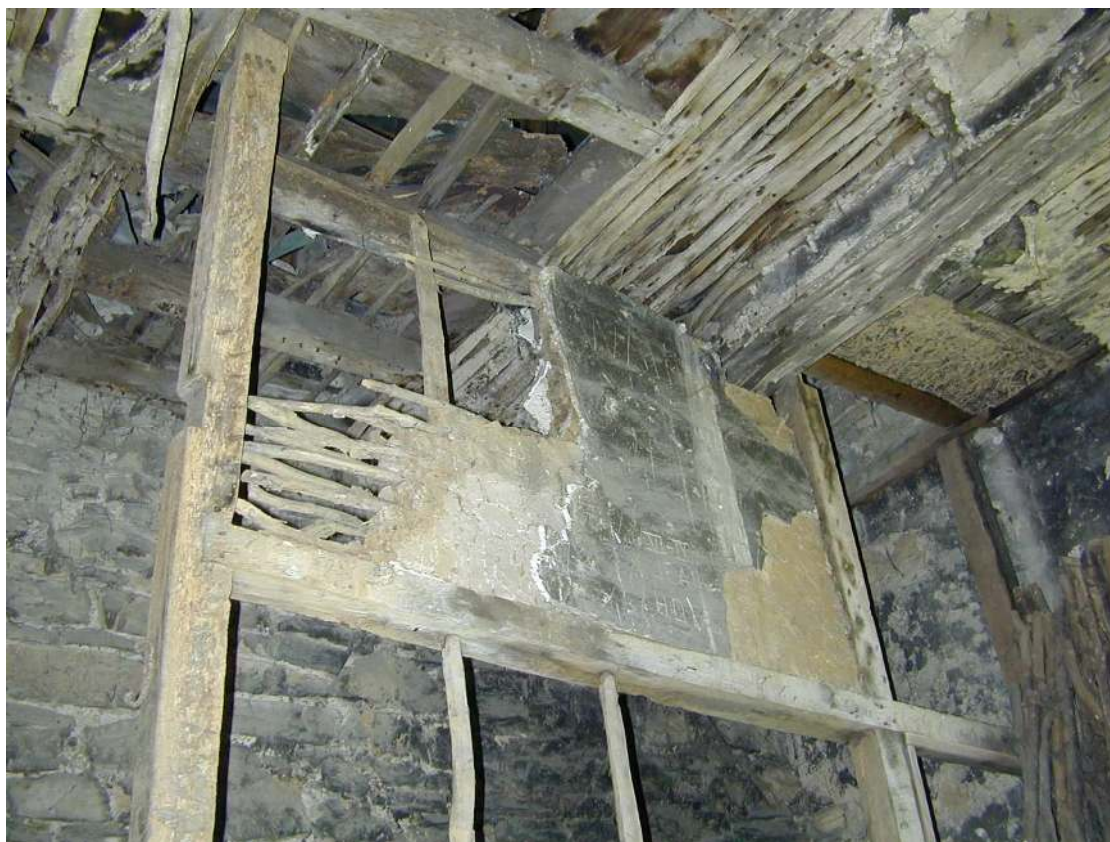
Fig. 44. Pavillon. 1 er étage. Pan de bois. IG 2002.
