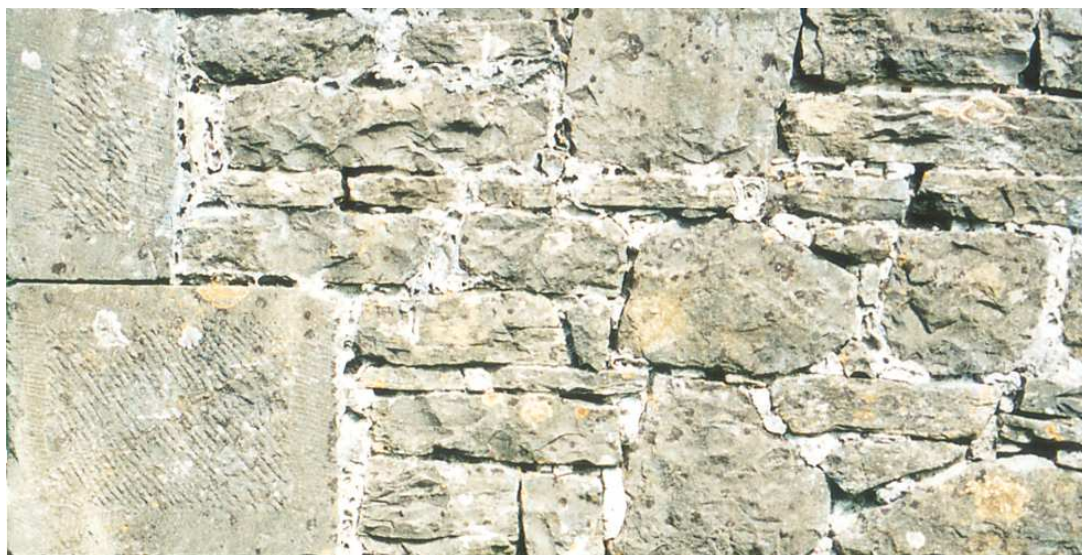
Fig. 82. Pavillon. Elévation SO. Détail de la maçonnerie en pierre. IG 2002.
