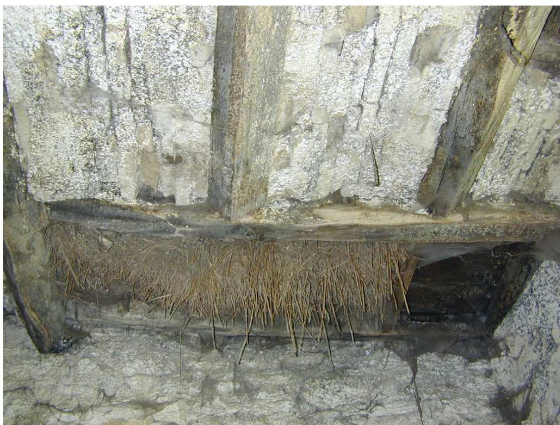
Fig. 40. Pavillon. Rez. Trémie de l'escalier vers le 1 er étage et plafond à entrevous et solives sur pointes. IG 2002.
