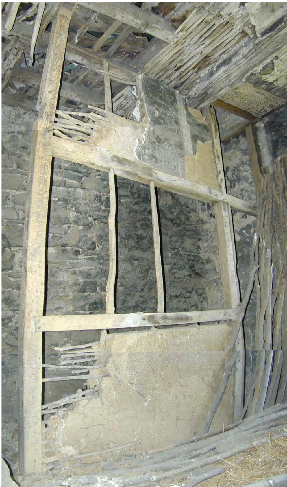
Fig. 113. 1 er étage. Pan de bois. Montage photo. IG 2007.
