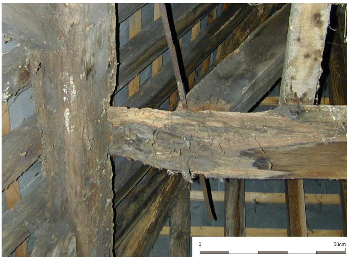
Fig. 156. Charpente. About d'un élément de l'enrayure au droit du versant NE. IG 2004.
