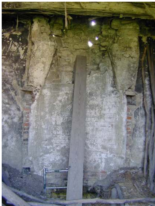
Fig. 42. Pavillon. 1 er étage. Cheminée. IG 2002.
