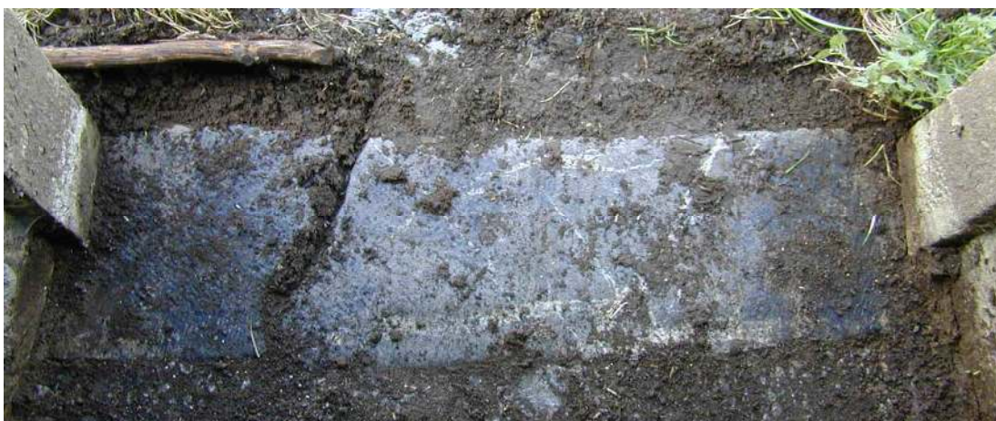
Fig. 115. Rez-de-chaussée. Seuil en pierre de la baie d'entrée, flanqué de béton. IG 2004.
