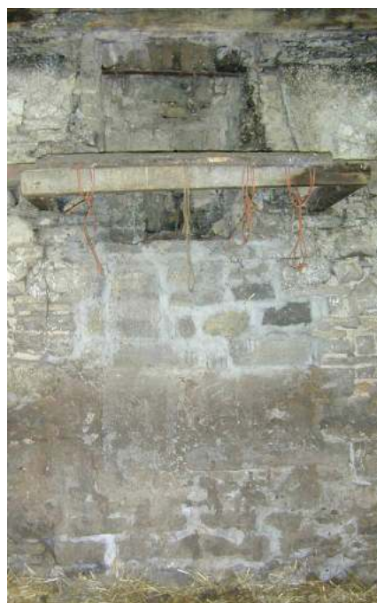
Fig. 136. Ouverture du conduit de cheminée du four. IG 2004.
