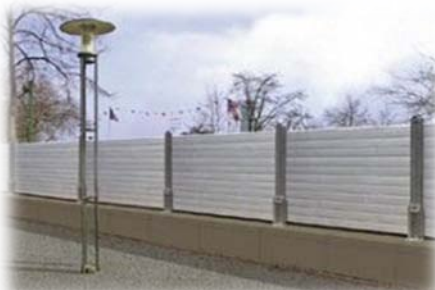
Rehausse de murs anti-crues
